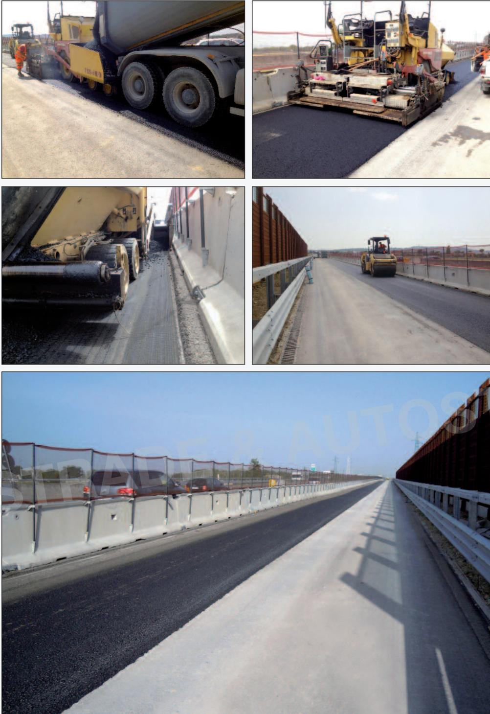
Figure 8, 9, 10, 11 e 12 - La stesa e la compattazione del nuovo conglomerato bituminoso, realizzato a caldo con bitume modificato con elastomeri SBS
