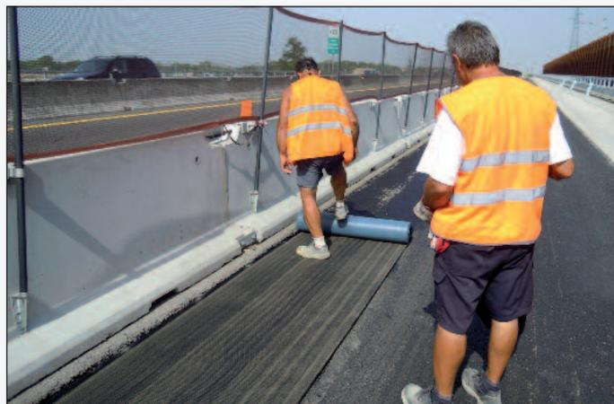
Figura 4 - La stesa del geocomposito in direzione longitudinale
