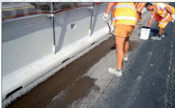
Figura 3 - La fase di trattamento della superficie fresata con una mano di attacco, previa pulizia con spazzolatura meccanica
