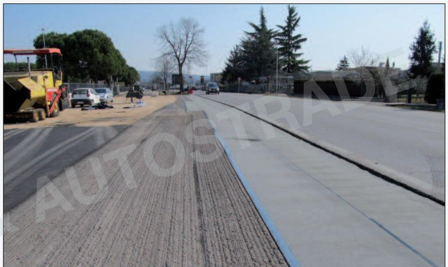
Figura 1 - La posa di Autotene Asphaltico Antipumping per l'impermeabilizzazione e il rinforzo nel rifacimento di una vecchia pavimentazione stradale
