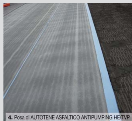
4. Posa di AUTOTENE ASFALTICO ANTIPUMPING HE/TVP
