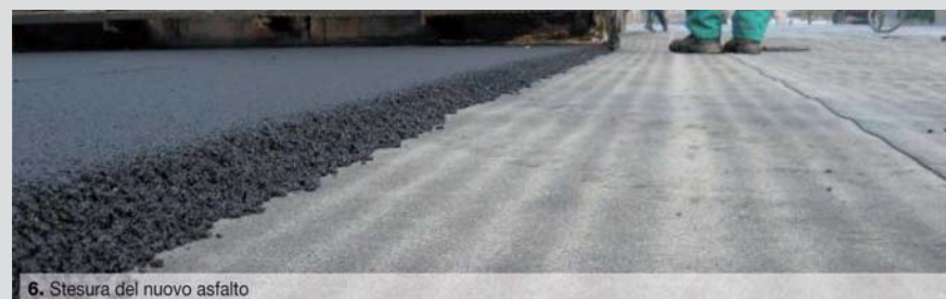
6. Stesura del nuovo asfalto
