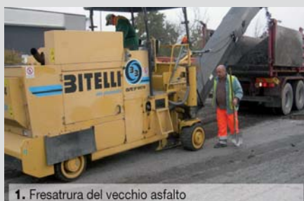
1. Fresatura del vecchio asfalto
