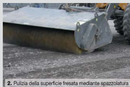
2. Pulizia della superficie fresata mediante spazzolatura
