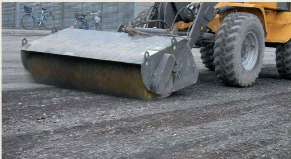
PULIZIA. Nel caso di rifacimento, dopo le operazioni di fresatura del vecchio asfalto, si procede alla pulizia della superficie di posa che dovrà risultare liscia, pulita ed asciutta.
