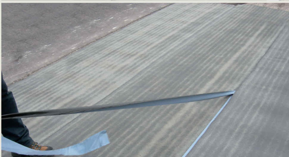
RIMOZIONE DEL FILM DELLA CIMOSA. Prima di procedere alla stesura del nuovo strato di usura, si toglie da sotto il sormonto longitudinale la fascia bisiliconata di protezione.
