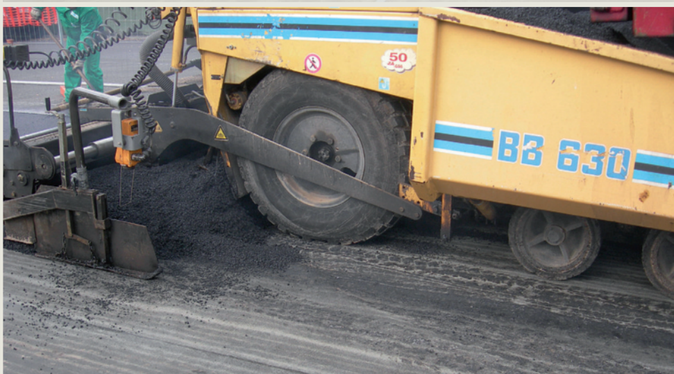
STESURA DEL NUOVO STRATO DI USURA. L'incollaggio definitivo al piano di posa è determinato dalle successive operazioni di stesura a caldo della pavimentazione di conglomerato bituminoso.
