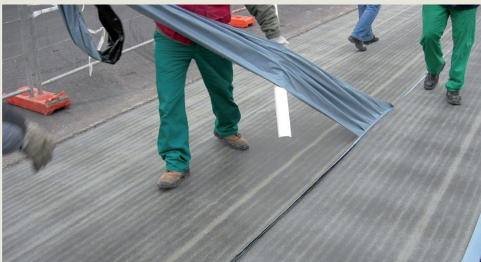
RIMOZIONE DEL FILM SILICONATO. Lasciando i fogli in posizione, si asporta da sotto il film siliconato della faccia inferiore dei teli che, per agevolare la posa, è stato previsto in due metà sovrapposte.
