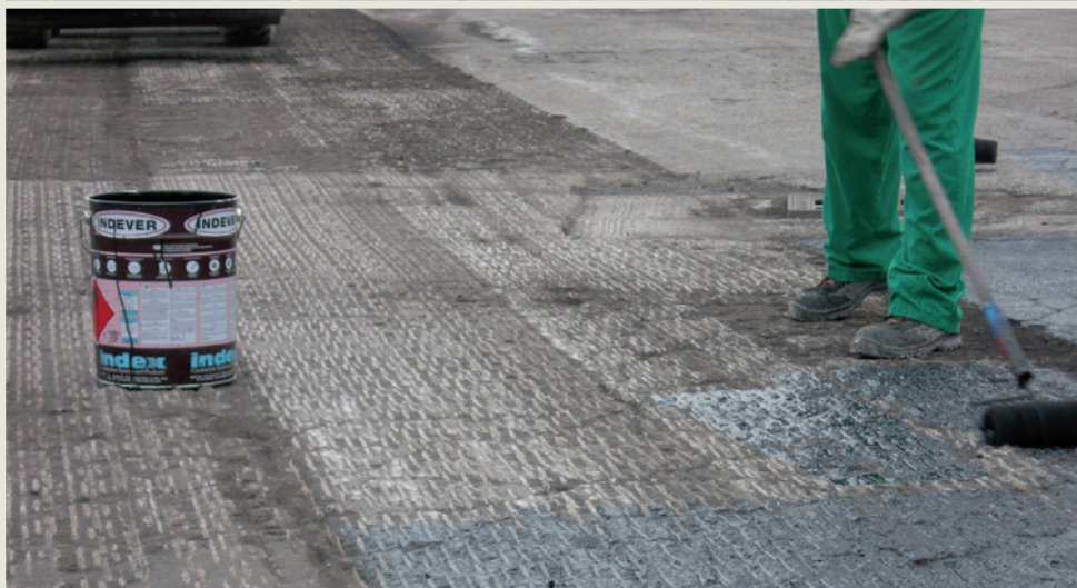
STESURA DEL PRIMER. Sulle superfici polverose per consentire un'ottimale adesione fra gli strati e stabilizzare la membrana è opportuno trattare il piano di posa con una mano di primer bituminoso Indever Autostrade.
