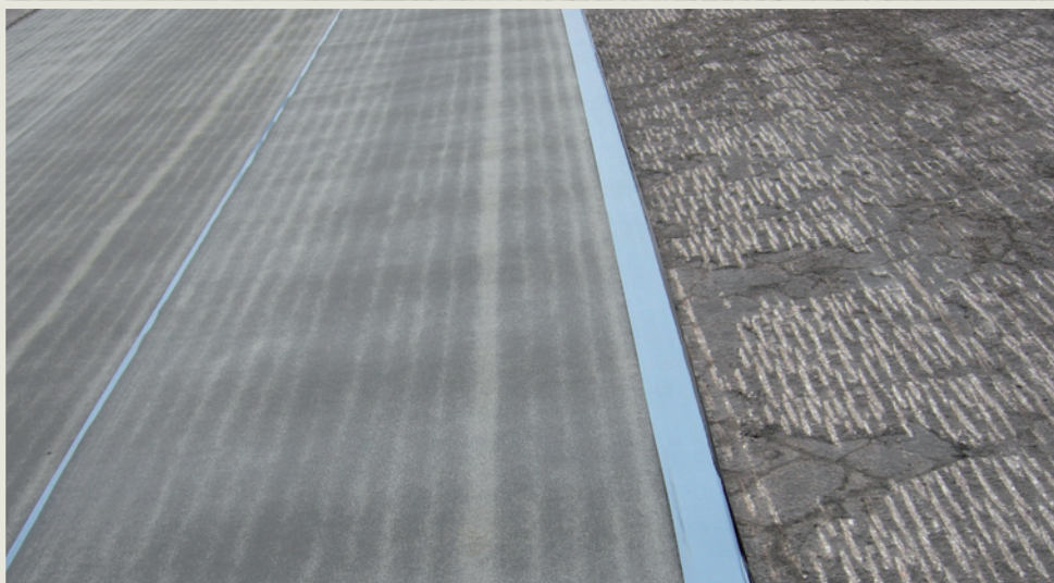
POSA DI AUTOTENE ASFALTICO ANTIPUMPING EP/TV. Si stende la membrana a secco allineando e sormontando longitudinalmente i teli lungo la striscia di sormonto prevista sulla faccia superiore dei fogli.
