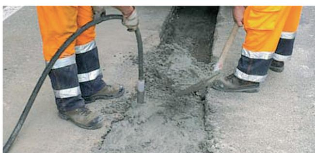
**Fig. 11** La vibratura del betoncino
