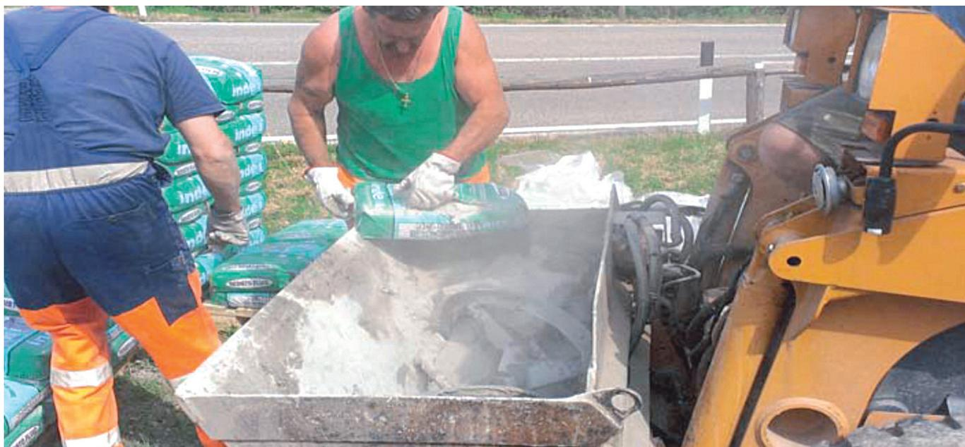
**Fig. 8** La preparazione della malta nella benna miscelatrice
