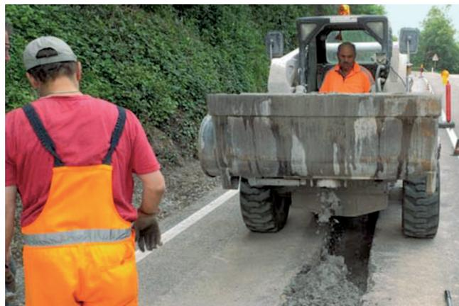
**Fig. 10** La fase di riempimento della trincea
