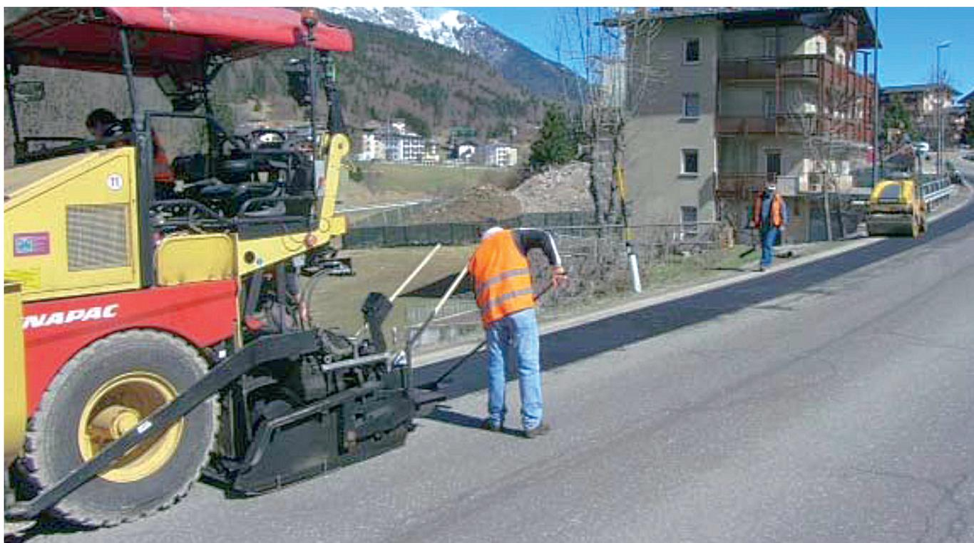
**Fig. 15** La stesa del conglomerato bituminoso
