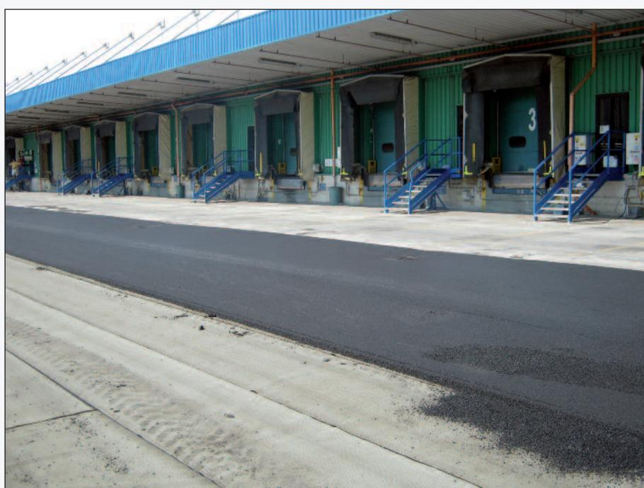
1. La pavimentazione in conglomerato bituminoso antistante la zona di carico dello stabilimento industriale della Fater SpA di Pescara presentava fessure a ragnatela leggera
