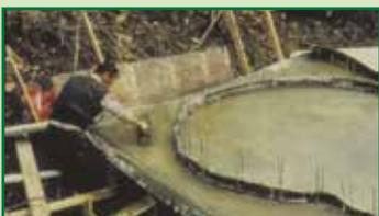
Getto in cls e lisciatura dello zoccolo destinato a ricevere l'impermeabilizzazione
