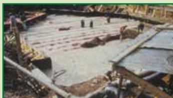
Particolare della fase di pompaggio per l'abbassamento della falda
