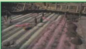
Posa del manto impermeabile direttamente sul magrone di fondo e successiva protezione con cappa
