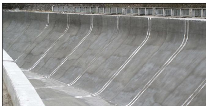
Canal hydroélectrique, application par pulvérisation
