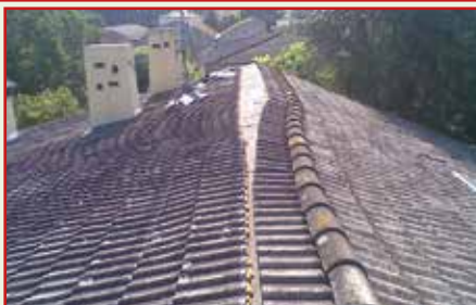
7. Saldare le sovrapposizioni di testa con HEADCOLL
