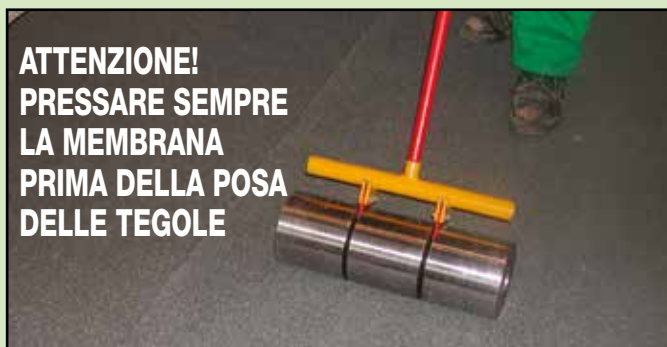
8. Pressatura generale prima della posa delle tegole
