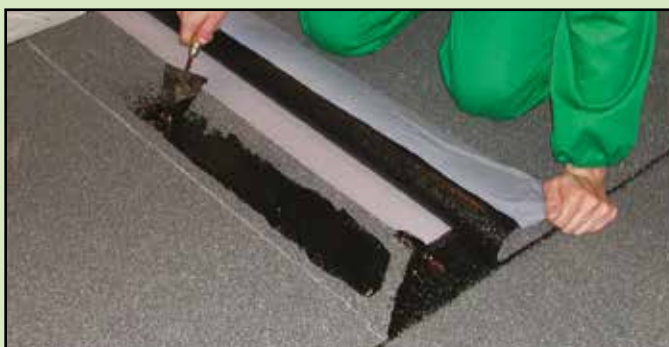
7. Saldare le sovrapposizioni di testa con HEADCOLL
