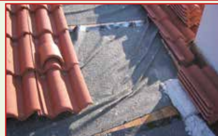
8. Pressatura generale prima della posa delle tegole
