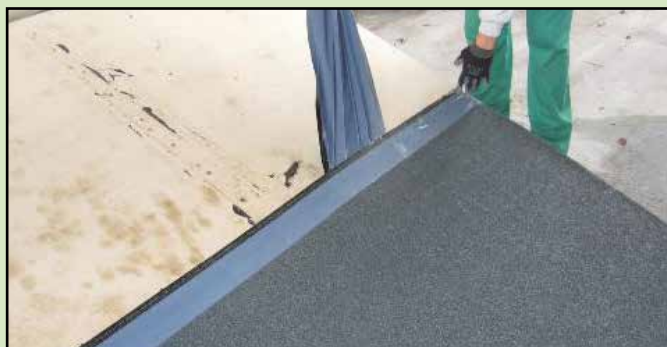
2. Incollare per autoadesione la membrana
