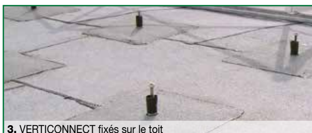
3. VERTICONNECT fixés sur le toit
