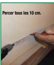
Percer à 5 cm au-dessus du sol.
