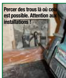
Percer dans le mur en profondeur
