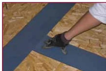
5. Il film siliconato della faccia superiore va tolto solo immediatamente prima dell'incollaggio del telo di membrana che vi si poserà sopra
