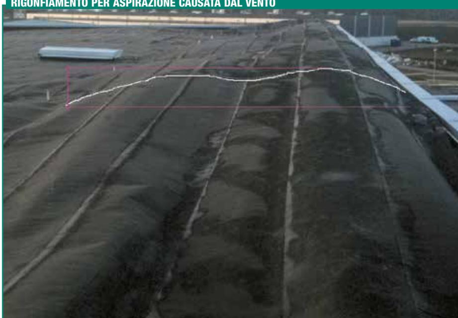
Ancora una volta si conferma che nel manto a vista è basilare che **la stratigrafia di copertura sia completamente solidale al supporto.**
