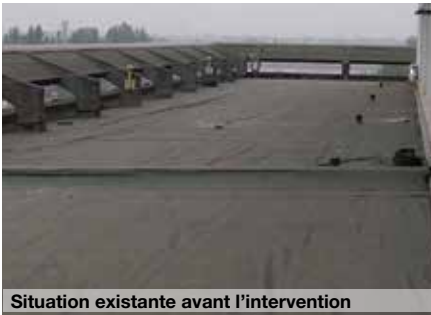
Situation existante avant l'intervention
