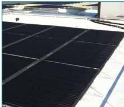
La faccia inferiore della membrana è rivestita con un film fusibile Flamina che ha un'elevata retrazione a contatto con la fiamma di applicazione mentre la faccia superiore è protetta da speciali scaglie minerali bianche, compatte, incollate ad alta temperatura, fatto salvo una fascia laterale di 8 cm ca. per permettere la saldatura delle sovrapposizioni.
