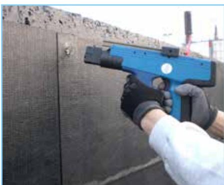
Le teste dei teli verranno fissate meccanicamente con 5 chiodi per metro lineare muniti di rondella di almeno 20 mm di diametro ed i sormonti di testa sorpasseranno di almeno 5 cm la rondella del fissaggio meccanico che verrà impostato ad almeno 3 cm dal bordo superiore.
