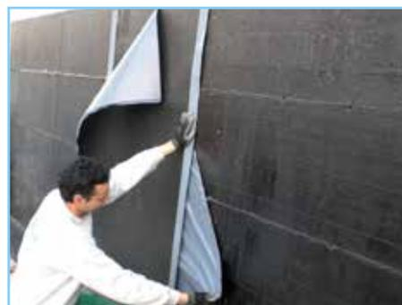
Si imposta il telo, si toglie il film su di un angolo e il telo si regge da solo, si ripete l'operazione sull'angolo opposto e dopo aver pressato il telo si incolla il sormonto.
