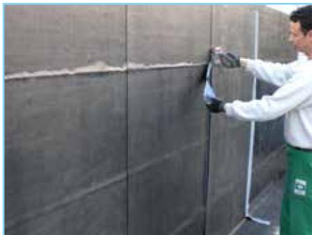
Sulle parti verticali i teli verranno tagliati in pezzi non più lunghi di 3 m. I fogli di **INDEXTENE HDPE SUPER** si impostano sulla parete e si asporta parzialmente da sotto la membrana la prima metà del film siliconato che ne riveste la faccia inferiore sulla parte alta del telo, pressando il foglio sul muro, poi si asporta dall'altro lato la seconda metà del film siliconato pressando accuratamente il foglio sulla superficie di posa, agendo dall'interno verso l'esterno dello stesso.
