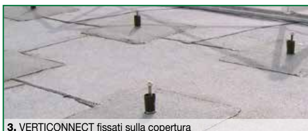
3. VERTICONNECT fissati sulla copertura
