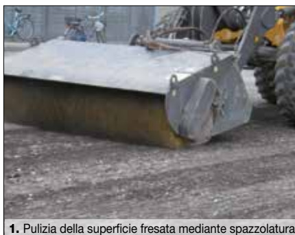
1. Pulizia della superficie fresata mediante spazzolatura
