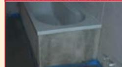
**Posa del rivestimento ceramico.** Come visto in precedenza si deve avere l'accortezza di posare il rivestimento ceramico staccato dalla pavimentazione. Dopo la posa si potrà disporre un cordolo di sigillatura elastico, un eventuale contatto rigido del rivestimento con il pavimento causerebbe un ponte acustico che penalizzerebbe l'isolamento fino a 12 dB.
