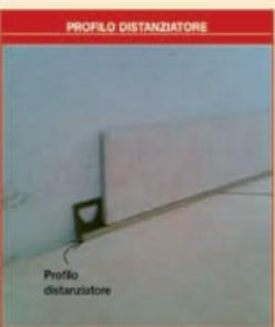
**Sigillatura elastica.** Dopo aver posato il battiscopa o il rivestimento ceramico staccato dalla pavimentazione si potrà disporre un cordolo di sigillatura elastico. Anche in questa ultima fase è da evitare la creazione di contatti rigidi con il pavimento che causerebbe un ponte acustico che penalizzerebbe l'isolamento.
