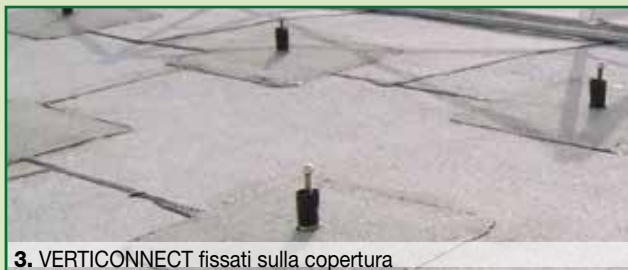
3. VERTICONNECT fissati sulla copertura
