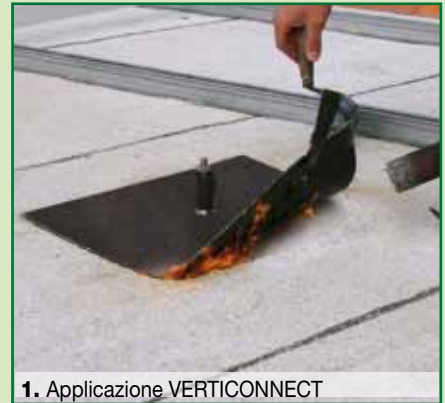
1. Applicazione VERTICONNECT
