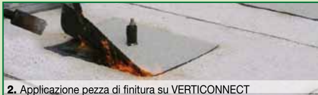
2. Applicazione pezza di finitura su VERTICONNECT
