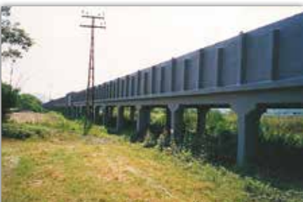
CANALE IDROELETTRICO Piemonte - ITALIA
