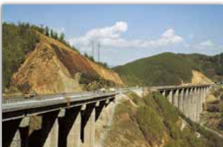
VIADOTTO "HEMUS" BULGARIA
