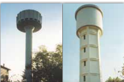
TORRI PIEZOMETRICHE Bologna - ITALIA
