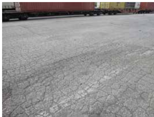
Area eseguita senza AUTOTENE ASFALTICO ANTIPUMPING
