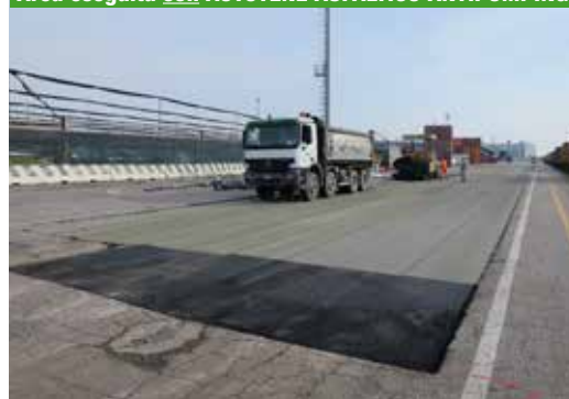
Area eseguita con AUTOTENE ASFALTICO ANTIPUMPING
