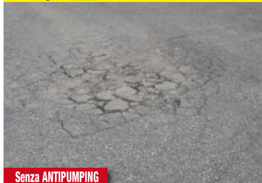
Area eseguita senza AUTOTENE ASFALTICO ANTIPUMPING
