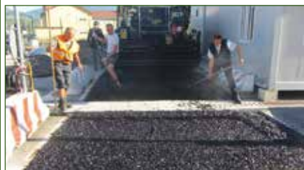
Stesura a caldo di un conglomerato aperto
