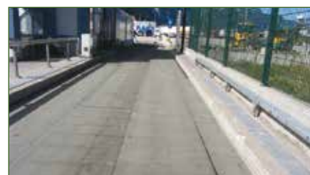
Stesura di AUTOTENE ASFALTICO ANTIPUMPING HE/TVP
