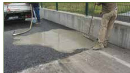
La saturazione delle porosità del conglomerato con una speciale malta cementizia BETON FLUID PRONTO ha lo scopo di aumentarne la portanza per sopportare il traffico pesante
