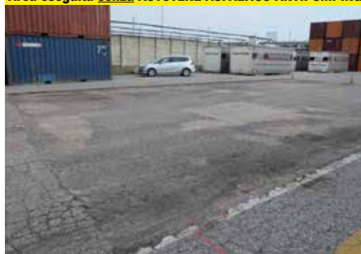
Area eseguita senza AUTOTENE ASFALTICO ANTIPUMPING
