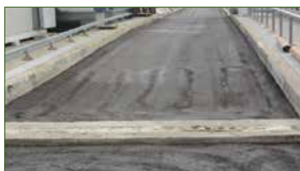
Le corsie sono attraversate da una trincea dove si alloggiavano gli impianti
