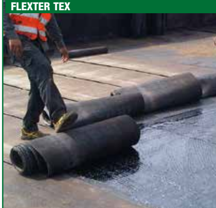
5. POSA DELL'ARMATURA RINFOTEX EXTRA
