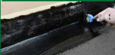
7. SECONDA MANO DI PURLASTIC FLASHING
