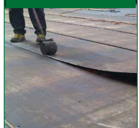
3. SALDATURA A FIAMMA DEI SORMONTI
