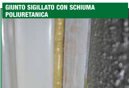
GIUNTO SIGILLATO NUOVAMENTE CON FONOELAST MONO
