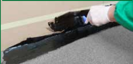
4. RISVOLTI IN VERTICALE. PRIMA MANO DI PURLASTIC FLASHING
