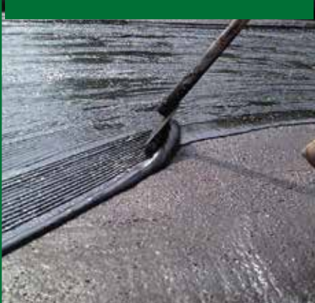
1. POSA DELL'ADESIVO MASTIPOL
