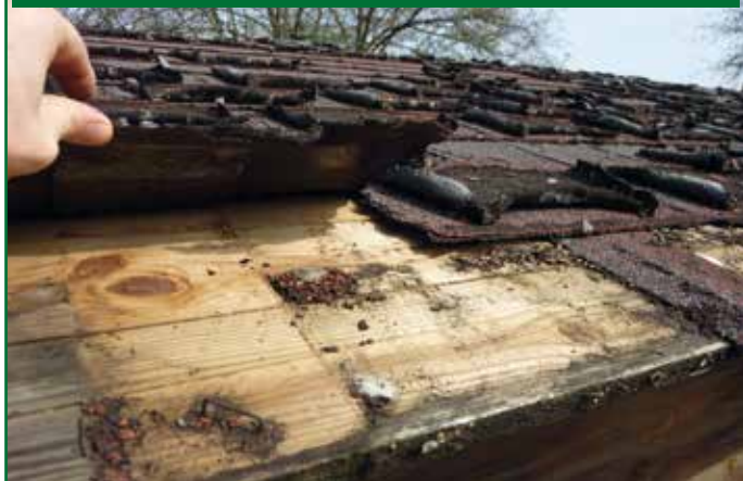
PRIMA: COPERTURA CON VECCHIE TEGOLE BITUMINOSE
