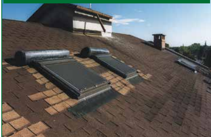
PRIMA: COPERTURA CON VECCHIE TEGOLE BITUMINOSE
