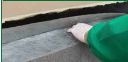
5. POSA DELL'ARMATURA RINFOTEX EXTRA
