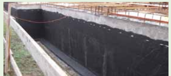
Proteger la impermeabilización con PROTEFON TEX o paneles PES
