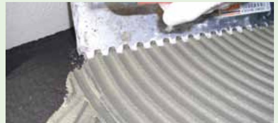
Sobre UNOLASTIC es posible colocar tablillas o tejas y fijarlas directamente sobre tiras de argamasa
