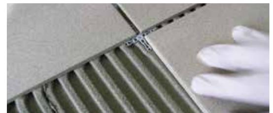
Sur UNOLASTIC, il est possible de poser des carreaux en utilisant les colles C2S1
