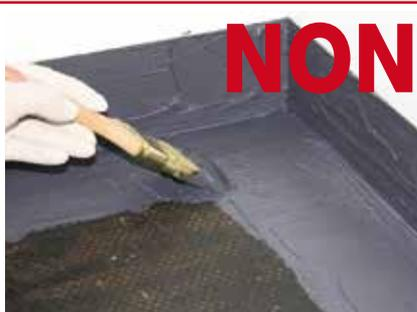
**Décrochement d'UNOLASTIC de la surface poudrée de la membrane**
