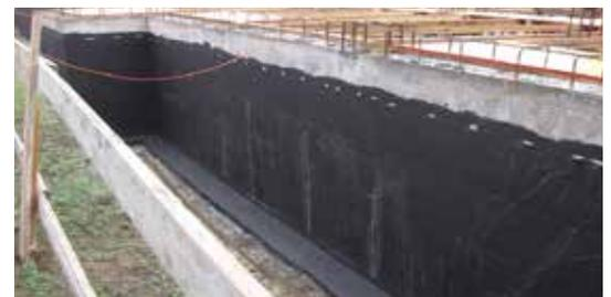
Protéger l'imperméabilisation avec PROTEFON TEX ou avec des panneaux en PSE
