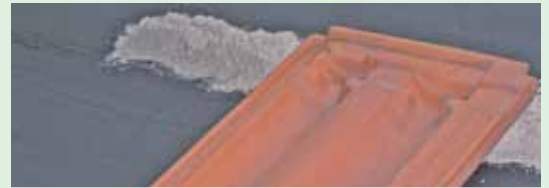
Στο UNOLASTIC μπορείτε να αποθέσετε πλέγματα ή κεραμίδια στερεώνοντάς τα απ' ευθείας σε "κράσπεδα" κονιάματος
