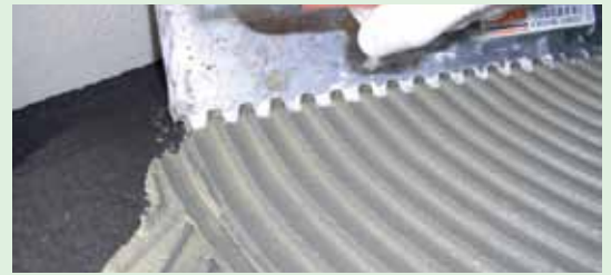
Στο UNOLASTIC μπορείτε να αποθέσετε πλέγματα ή κεραμίδια στερεώνοντάς τα απ' ευθείας σε "κράσπεδα" κονιάματος
