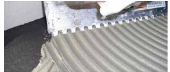
Auf UNOLASTIC können Holzziegel oder Dachpfannen direkt auf Mörtelanker verlegt werden
