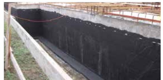
Die Abdichtung mit PROTEFON TEX oder EPS-Platten schützen
