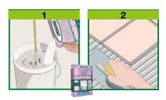
obtention d'une pâte homogène et sans grumeau (1). Laissez reposer le gâchage pendant 3 minutes et mélangez à nouveau. Le mélange se conserve et est utilisable pendant environ 6 heures en fonction des conditions climatiques.
