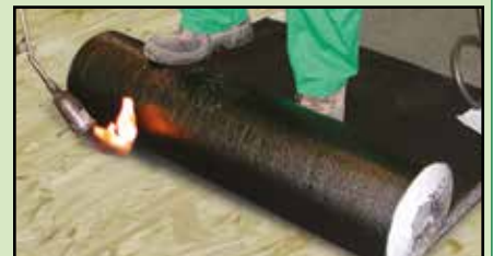
3. Torch lay the MINERAL TECTENE TEGOLA EP membrane
