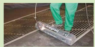
Colocación por llama de la cara inferior de TECTENE BV STRIP EP
