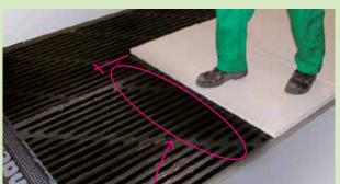
Los paneles aislantes puestos sobre la superficie que acaba de llamearse se hacen adherir al TECTENE BV STRIP EP mediante presión, simplemente con las pisadas del operador (que debe efectuar sobre la superficie entera del panel).
