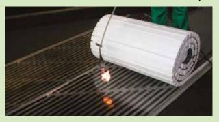
Los rollos de THERMOBASE desenrollados sobre la superficie que acaba de llamearse se hacen adherir al TECTENE BV STRIP EP mediante presión sobre la superficie entera del rollo, simplemente con las pisadas del operador (que debe efectuar sobre la superficie entera del panel o rollo).
