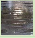
Si se insiste con el llameado, las tiras termoadhesivas asumen una consistencia semilíquida y brillante: la superficie estará lista para la colocación de los paneles o rollos de aislante
