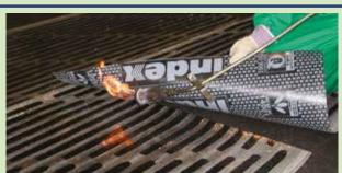
Colocación por llama de los solapamientos laterales y del solapamiento frontal para garantizar un sellado perfecto contra el paso de vapor.
