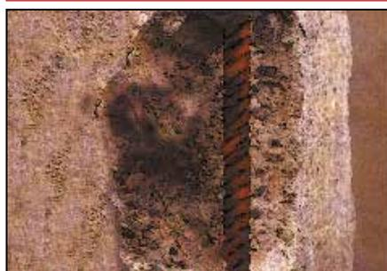
La formazione di ruggine sui ferri d'armatura del calcestruzzo, provocata da diversi fattori, causa distacchi e fessurazioni. I ferri affioranti vengono esposti ad una corrosione veloce che provoca il deterioramento rapido del calcestruzzo, compromettendo la stabilità delle strutture.
