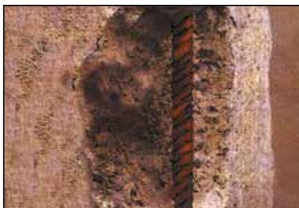
La formation de rouille sur les fers d'armature du béton, due à différents facteurs, provoque écailllements et fissures. Les fers affleurants sont exposés à une corrosion rapide qui détériore immédiatement le béton en compromettant la stabilité des structures.
