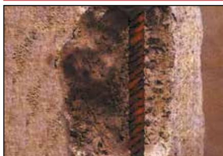
La formazione di ruggine sui ferri d'armatura del calcestruzzo, provocata dai diversi fattori, causa distacchi e fessurazioni. I ferri affioranti vengono esposti ad una corrosione veloce che provoca il deterioramento rapido del calcestruzzo, compromettendo la stabilità stessa delle strutture.
