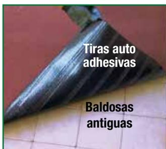
Se ejerce una presión adecuada sobre la mitad del rollo donde se retiró la película de silicona para realizar la adhesión en el soporte.
