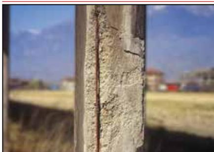
In alcuni interventi di ripristino del calcestruzzo sono richiesti spessori elevati senza l'utilizzo di cassetture. Le riparazioni degli spigoli di travi o pilastri, frontalini, formazioni di gusce di raccordo parete-pavimento richiedono malte con elevata tixotropia, e a ritiro compensato per evitare la formazione di crepe o cavillature da ritiro.
