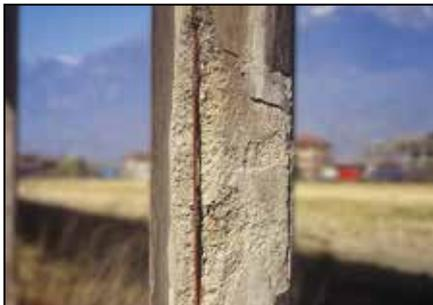
Gewisse Instandsetzungsarbeiten von Beton setzen hohe Dicken ohne die Verwendung von Schalungselementen voraus. Das Ausbessern von Träger- und Pfeilerkanten sowie Frontplatten und die Erstellung von Hohlkehlen zur Wand-Boden-Verbindung erfordern Mörtel mit hoher Thixotropie und einen guten Schwundausgleich, damit sich durch die Schwindung keine Spalten oder Haarrisse bilden.
