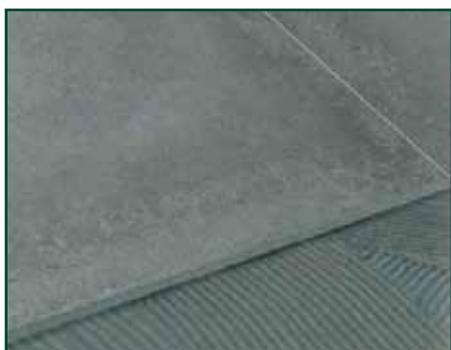
**Posa su massetto con colla.** È la posa ideale per rivestire aree carrabili in esterno, parcheggi auto, rampe di garage, essendo la superficie posata estremamente resistente sia ai carichi dinamici che a quelli concentrati. Sono necessari i giunti dilatazione e le fughe tra le lastre devono essere riempite con stucco cementizio.
