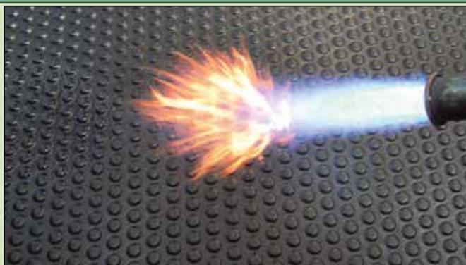
En insistant avec le flambage dans la même zone, la coloration de la flamme virera du bleu au rouge-orange : **la surface est prête pour la pose des panneaux.**
