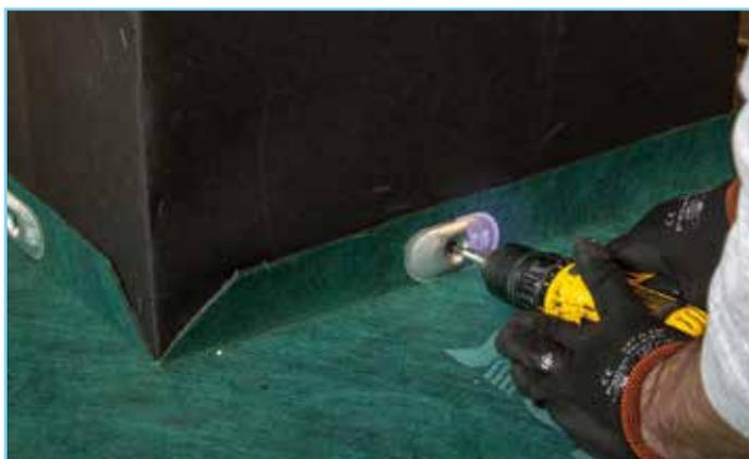
2. Applicazione di una pezza di rinforzo di membrana **POLYFOIL TRIATEX** in corrispondenza dello spigolo.
