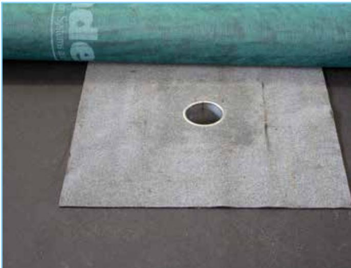
2. Incidere **POLYFOIL TRIATEX** in corrispondenza del foro dello scarico.
