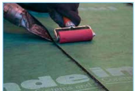
La saldatura dei teli sulle parti piane possono essere eseguite con saldatore ad aria calda automatico.
