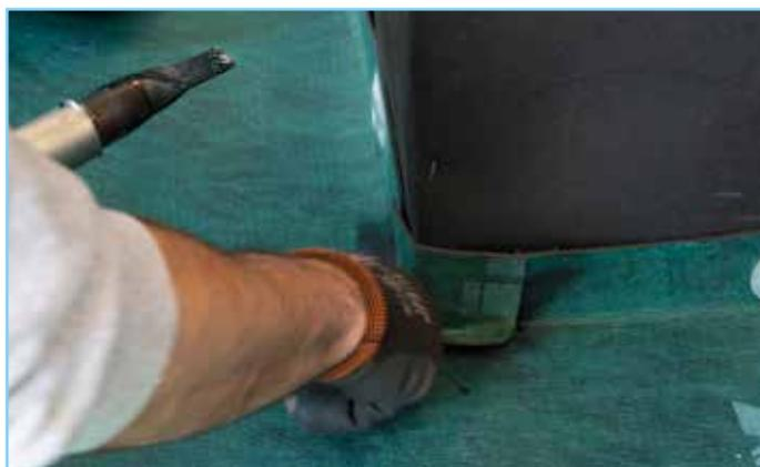
3. Preparazione e posizionamento della membrana per il risvolto verticale dell'angolo esterno. Successiva sigillatura ad aria calda dei sormonti.
