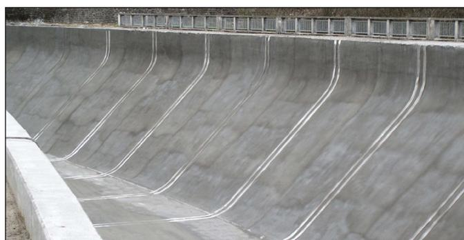
Canal hidroeléctrico, aplicación con pulverizador.
