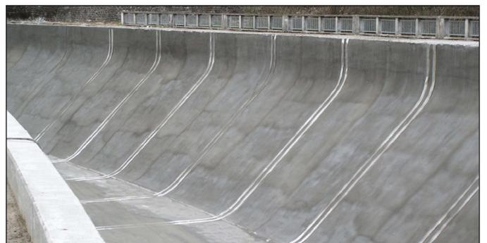
Hydroelektrischer Kanal, Sprühauftragung
