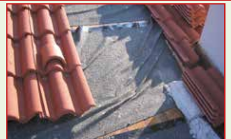
8. Prensar la membrana antes de colocar las tejas
