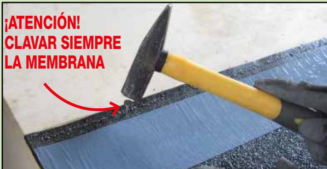
3. Clavar la membrana sobre la tira sin adhesivo
