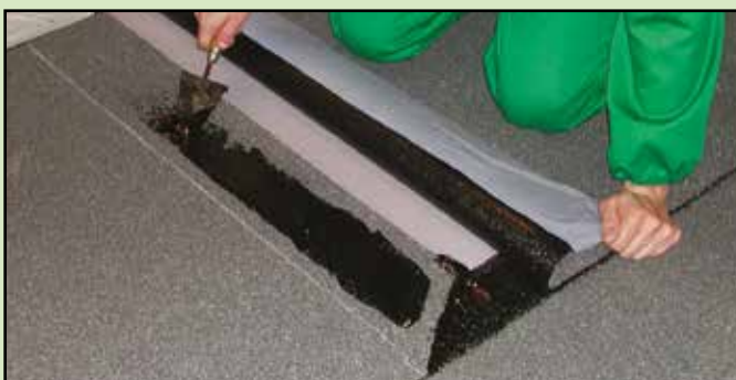
7. Soldar las superposiciones de cabecera con HEADCOLL
