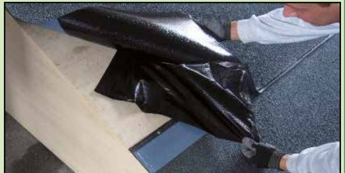
4. Colocar la membrana sucesiva
