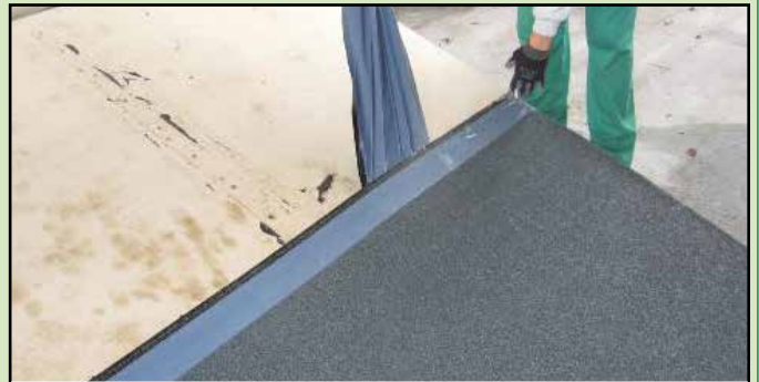
2. Encolar la membrana para autoadherencia
