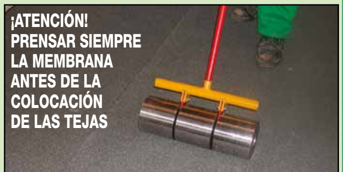
8. Prensar la membrana antes de colocar las tejas
