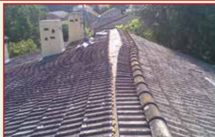
7. Soldar las superposiciones de cabecera con HEADCOLL
