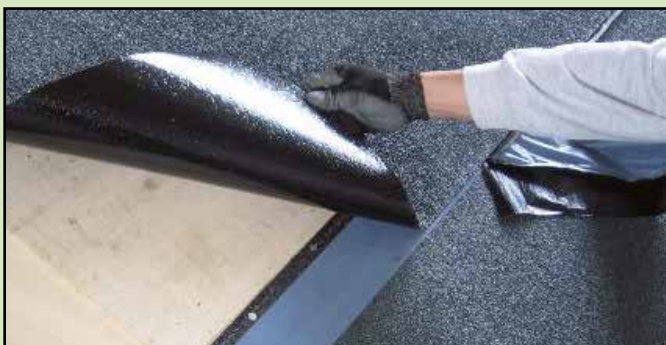
5. Recubrir el solapamiento
