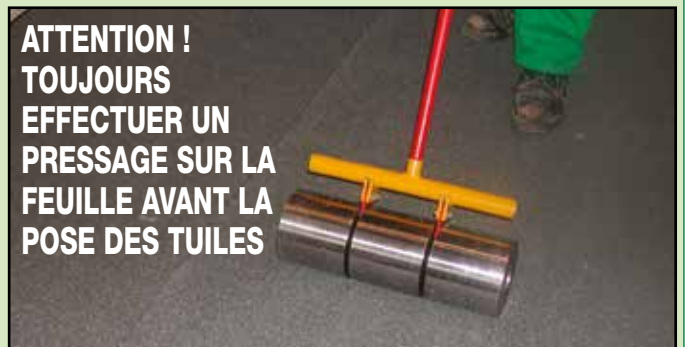
8. Pressage général avant la pose des tuiles
