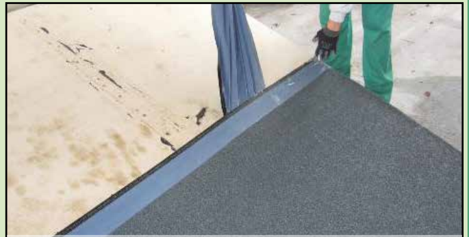
2. Autocoller la membrane
