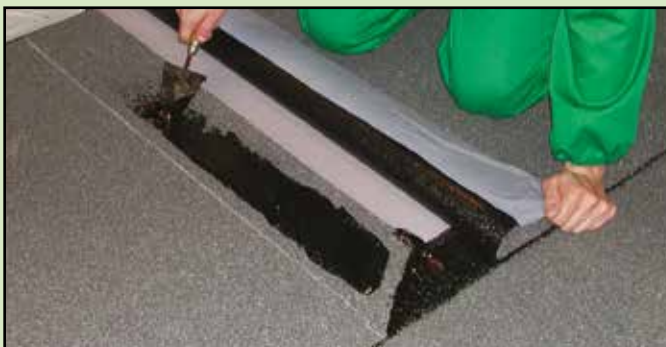
7. Souder les superpositions d'extrémité avec HEADCOLL
