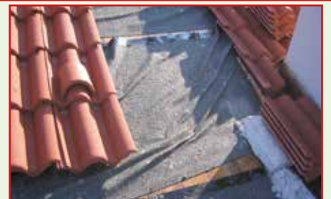
8. Pressage général avant la pose des tuiles
