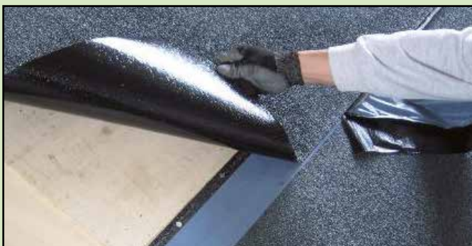
5. Recouvrir le chevauchement
