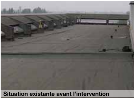
Situation existante avant l'intervention
