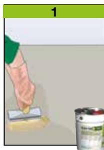
mit einer Schicht POLIDUR PRIMER verfestigt und behandelt werden (1) (mindestens 8 Stunden warten, bis der Klebstoff **LIGNUM AB** aufgetragen werden kann) wodurch eine ausreichende Haftung des Klebstoffs begünstigt wird.
