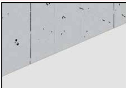
En distintas obras de restablecimiento con distintos tipos de argamasa a menudo se presenta el problema de la escasa adherencia sobre soportes demasiado lisos, arenosos o viejos e irregulares.
