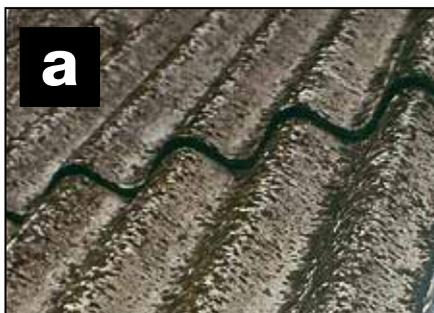
La bonifica delle lastre di copertura in cemento amianto assume sempre maggiore importanza, ai fini ambientali per la pericolosità determinata dalla continua dispersione delle fibre di amianto nell'ambiente.
