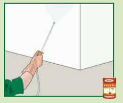
und 50 cm weit abtropft. Bei kleinen Oberflächen ist auch ein Auftragen mit einer Rolle oder einem Pinsel möglich, sofern die angewendete Menge den Untergrund ausreichend imprägniert. Oberflächen aus Holz, Glas oder Kunststoff müssen während des Auftragens geschützt werden.
