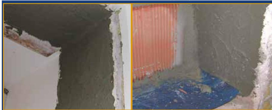
FONOPLAST gewährleistet als entkoppelnde Schicht eine Dämpfung der „Stoßgeräusche“ gemeinschaftlich genutzter Treppenhäuser und Flure
