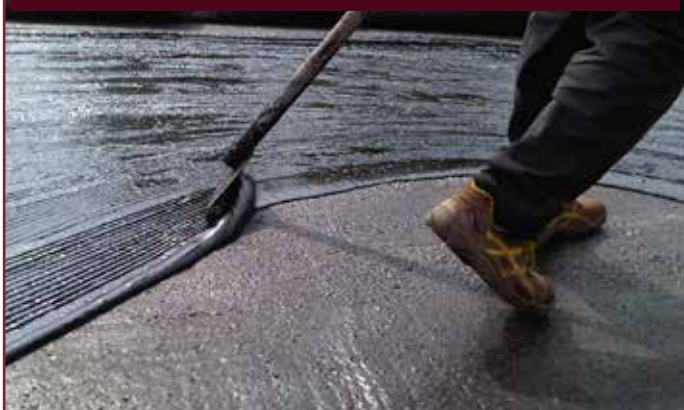
POSE DE LA COLLE MASTIPOL
